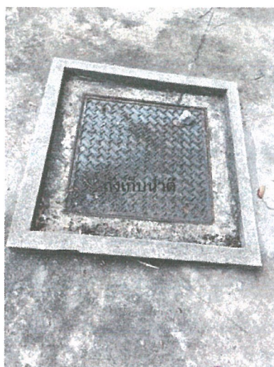
รูปภาพที่ 2.20 ถังเก็บน้ำสำรองใต้ดิน
