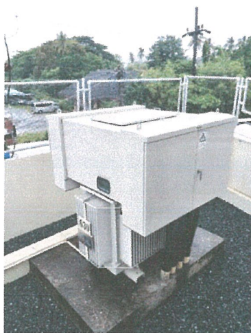
รูปภาพที่ 2.14 หม้อแปลงไฟฟ้า
